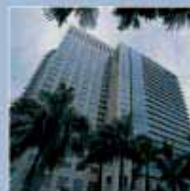
Системы повышения давления
